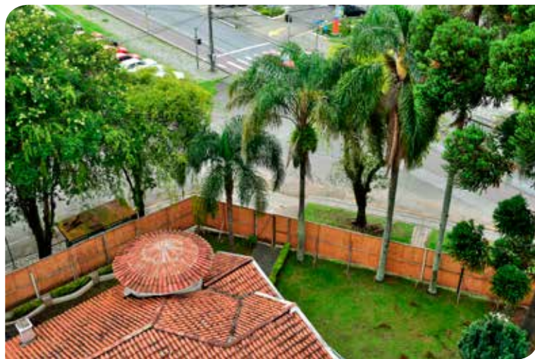
Vista parcial do terreno ao lado da sede do CRCPR, onde será construída nova área de estacionamento.
